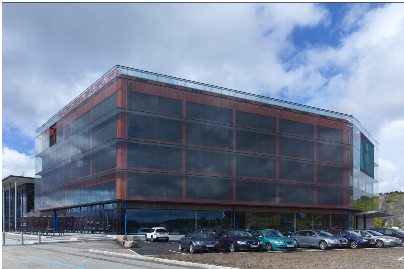
Bottenplan mot Göta älv med Sapa Fasad 4150 SSG (Structural Sealant Glazing) samt Sapa Fasadfönster 4074 med motorstyrning för ventilation och Sapa Dörr 2074.
