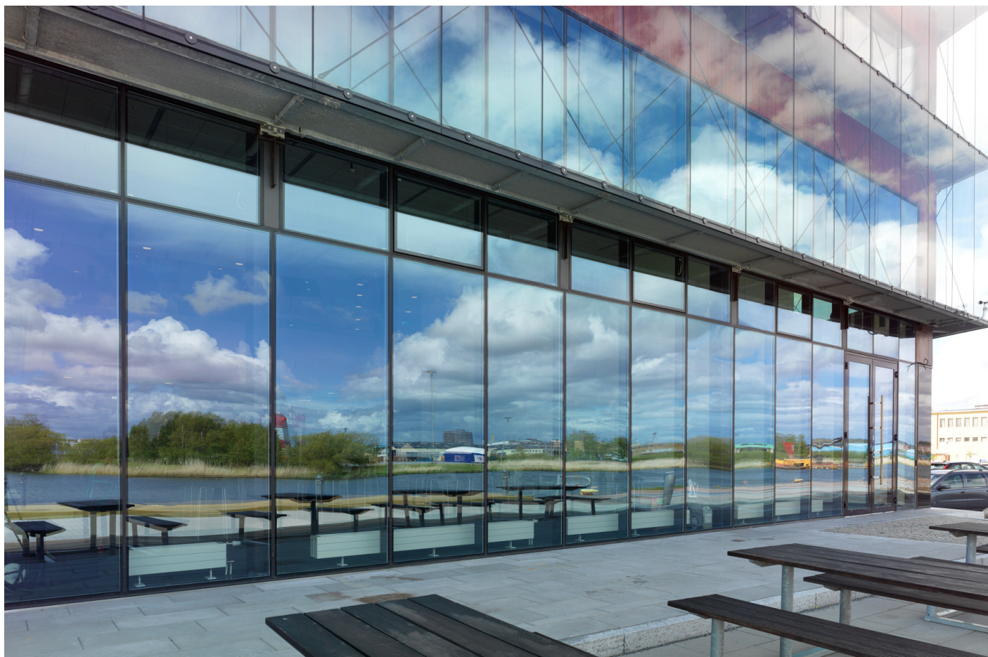
Bottenplan mot Göta älv med Sapa Fasad 4150 SSG (Structural Sealant Glazing) samt Sapa Fasadfönster 4074 med motorstyrning för ventilation och Sapa Dörr 2074.
